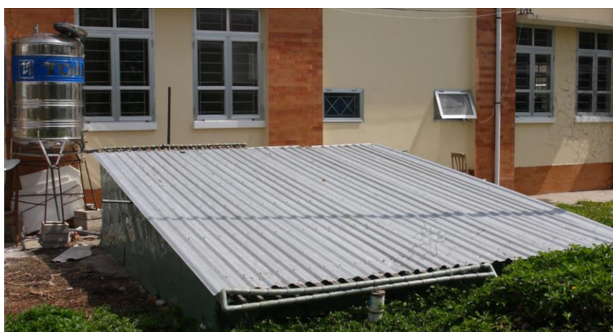
Hình 9. Sau khi hoàn tất hệ thống
