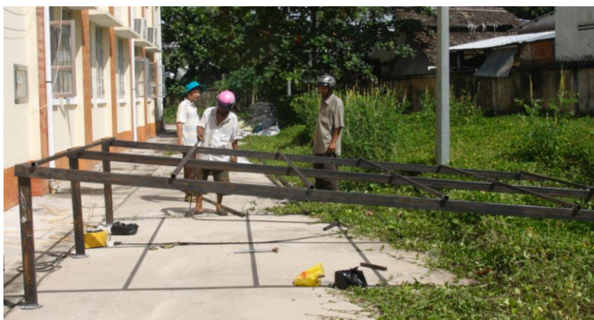
Hình 7. Lắp khung chịu lực
