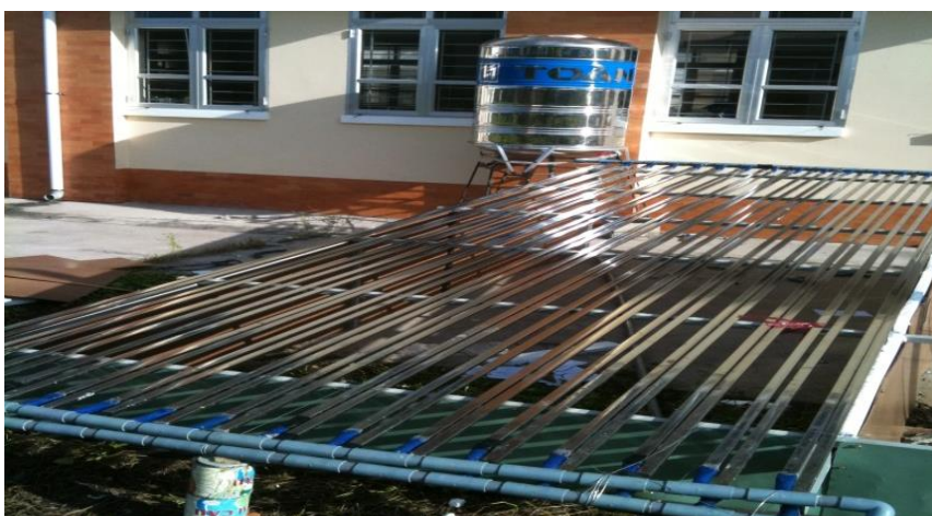
Hình 8. Sau khi lắp ống hấp thu nhiệt
